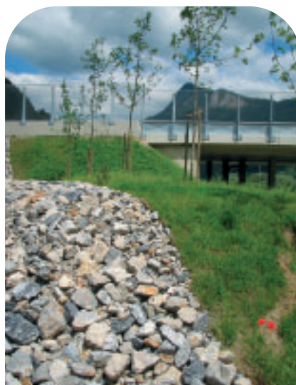
Beinahe unsichtbarer, transparenter Lärmschutz mit Landschaftsgestaltung S 35, Traföß/Stmk.
