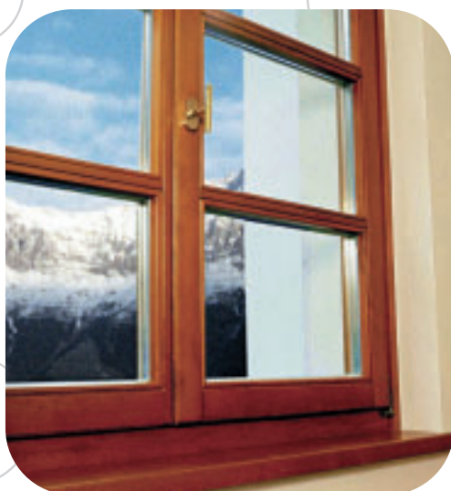
Spezialfenster aus dem Hause Rieder: Das Lawinenschutz-Fenster
