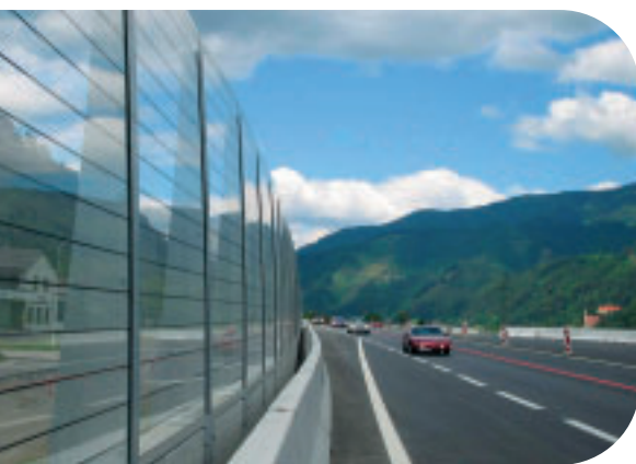
Zeitgenössisches Design für Lärmschutz in einem Gestaltungskonzept für die S35, Traföß/Stmk. eingebunden
