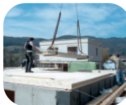
Das erste erfolgreich errichtete Einfamilienhaus
