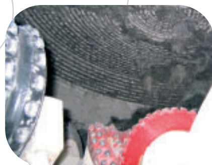
Bohrlochprofil mit zurückgezogenem Bohrkopf
