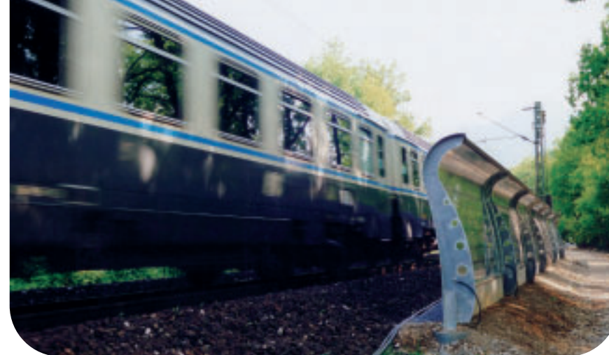
Freier Blick vom Waggonfenster mit gleicher Lärmschutzwirkung wie eine herkömmliche Wand (von 4 m Höhe), Brannenburg/Bayern
