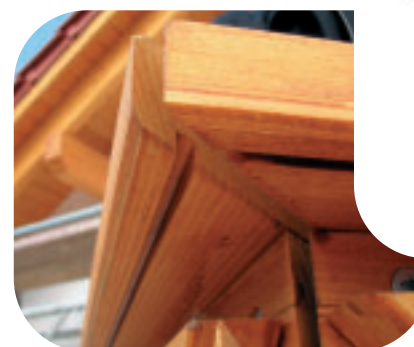
Der Handlauf ist ein extrem beanspruchtes Bauteil von Balkonen
